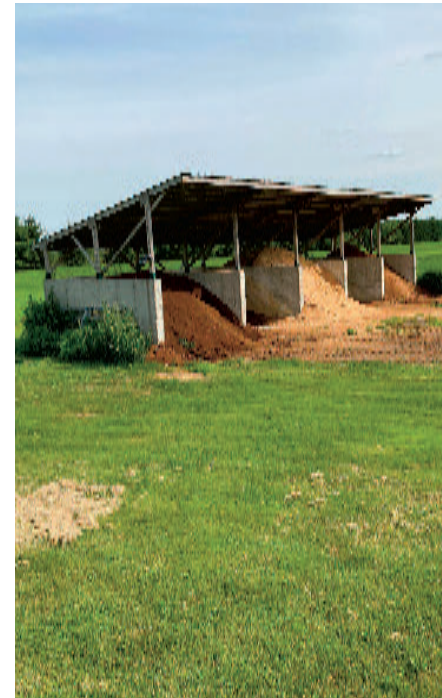
La structure comportant les cinq cellules est en béton.
