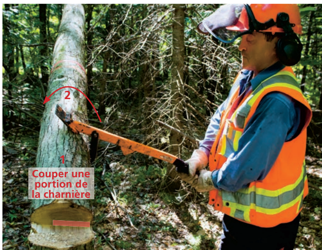
Pour dépendre un arbre encroué, on le tourne avec le crochet tourne-bille du levier d'abattage. Si le diamètre de l'arbre est trop grand pour le crochet, le bûcheron effectue une entaille dans l'arbre avec sa scie et y insère la pointe du levier d'abattage (photo de droite).
